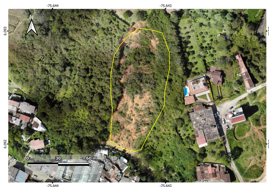
Figura 5: Ortomosaico de sobrevuelo realizado el 17 de noviembre de 2023 sobre el deslizamiento La Valeria. No se evidencia obstrucción en el canal en el pie del deslizamiento. Persiste el muro de gaviones como estructura de protección de la socavación lateral.
