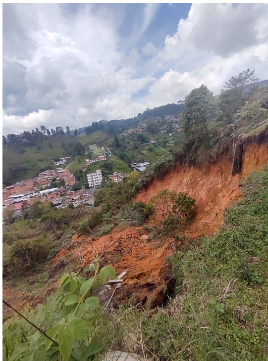
Figura 6: Escarpe principal del deslizamiento La Valeria. Nótese el avance de la corona con caída de árboles y afectaciones en el enrejado perimetral de un predio privado.
