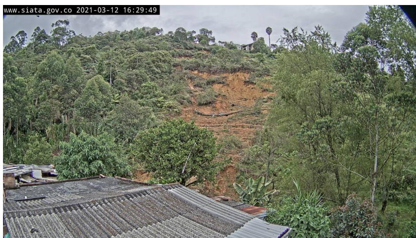
Figura 7: Fotografías de la cámara de monitoreo del deslizamiento. Fotografía registrada el 12 de marzo de 2021. Se observan las obras superficiales de estabilización en mal estado (trinchos de madera). Se observan escarpes secundarios debido al desplazamiento paulatino de la masa de suelo.
