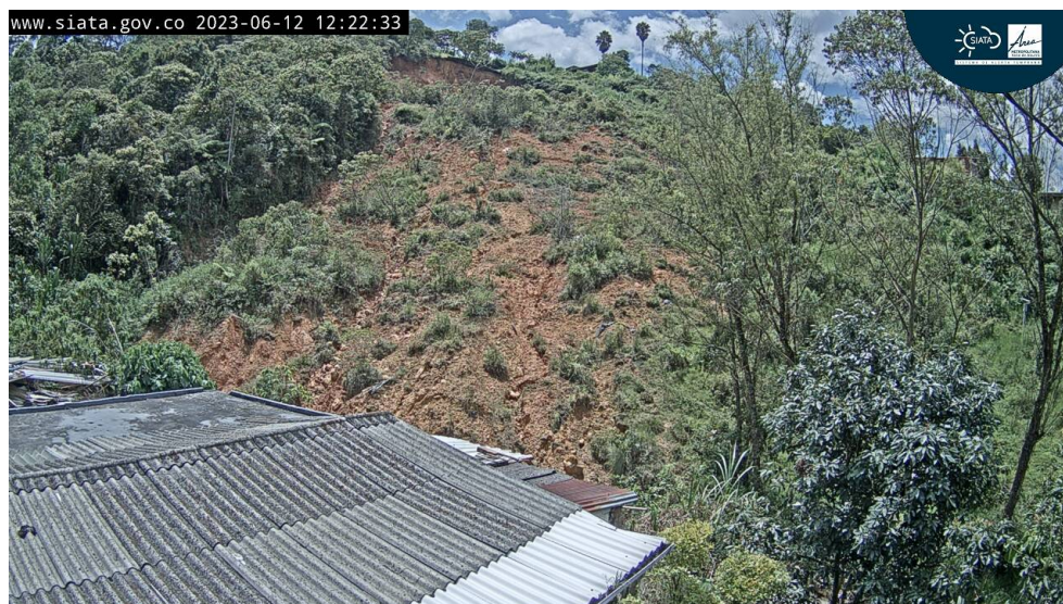
Figura 9: Fotografías de la cámara de monitoreo del deslizamiento. Fotografía registrada el 12 de junio de 2023. Se observan avances en la erosión superficial del cuerpo del deslizamiento donde se evidencian surcos con un grado de incisión mayor.
