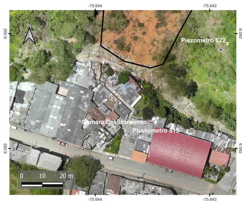
Figura 4: Ortomosaico de sobrevuelo realizado en septiembre de 2022 sobre el pie del deslizamiento y asentamiento humano expuesto. Nótese la cercanía del asentamiento urbano a la quebrada La Valeria, el estrechamiento del cauce producto del movimiento en masa en esta sección y el muro de gaviones como estructura de protección al asentamiento.
