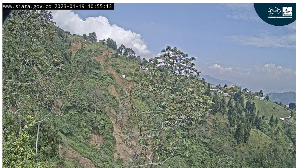
Figura 16: Fotografía de la cámara deslizamiento 1 registrada el 19 de enero de 2023. Nótese la evolución de la cárcava y los movimientos en masa en uno de los flancos de esta.
