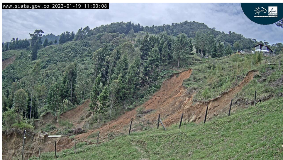
Figura 20: Fotografía de la cámara deslizamiento 2 registrada el 19 de enero de 2023. Cámara de monitoreo reubicada debido a la reactivación del deslizamiento. Nótese la ubicación de la edificación residencial de la señora “Blanca”.
