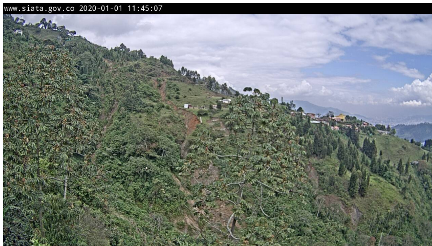
Figura 12: Fotografía de la cámara deslizamiento 1 registrada el 1 de enero de 2020. Se observan los procesos erosivos en la zona y actividad en los deslizamientos de la parte alta de la microcuenca.
