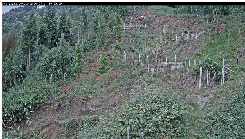
Figura 18: Fotografía de la cámara deslizamiento 2 registrada el 1 de enero de 2020. Nótese el deterioro de las obras de estabilización (trinchos de madera) realizadas al deslizamiento materializado en el año 2017.
