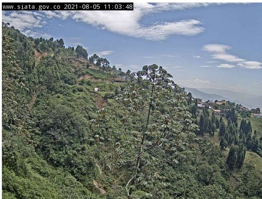
Figura 13: Fotografía de la cámara deslizamiento 1 registrada el 5 de agosto de 2021. Nótese la reactivación del deslizamiento intervenido en la esquina superior izquierda de la fotografía.
