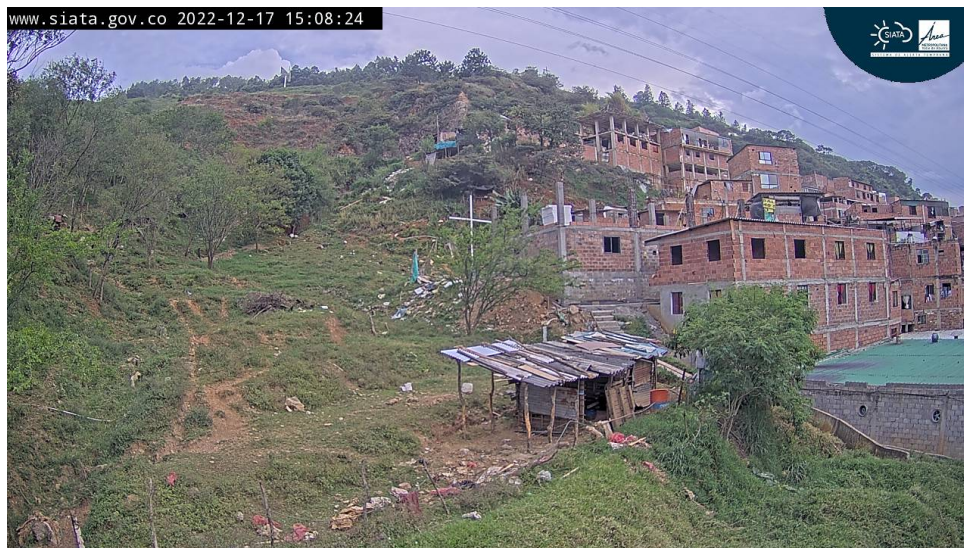
Figura 7: Fotografías de la cámara de monitoreo del deslizamiento. Fotografía registrada el 17 de diciembre de 2022. Se observan cambios en la vegetación y depósito de desechos antrópicos.
