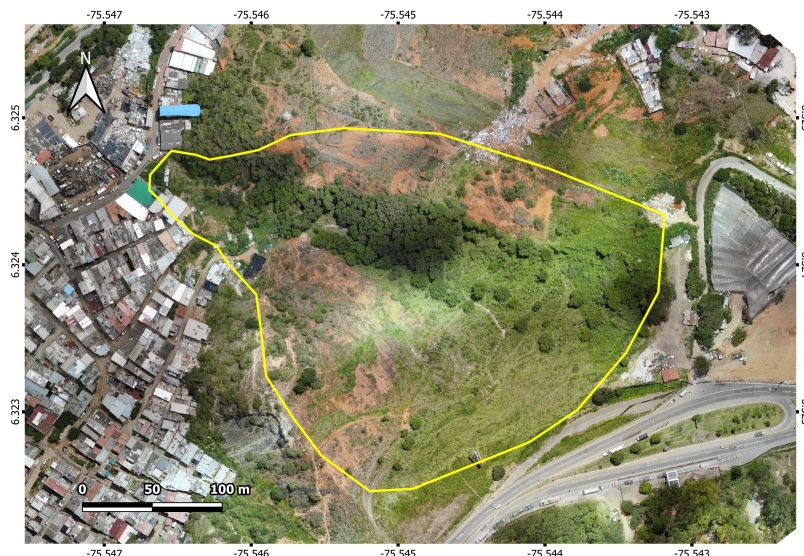
Figura 5: Ortofoto del sitio monitoreado realizado mediante sobrevuelo de drones el 15 de junio de 2023. Se observa la leve recuperación de la cobertura vegetal y los procesos de erosión laminar activos en forma de surcos por todo el movimiento en masa.
