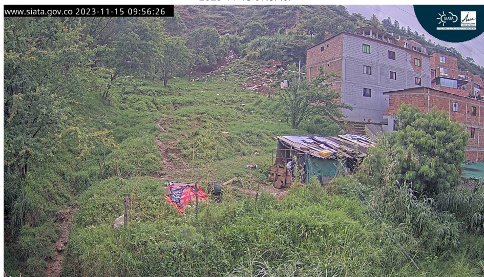
Figura 8: Fotografías de la cámara de monitoreo del deslizamiento. Fotografía registrada el 15 de noviembre de 2023. Se observan cambios en la vegetación, depósito de desechos antrópicos y la construcción de una vivienda en materiales simples en el cuerpo del deslizamiento.
