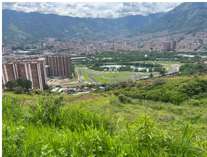
Figura 9: Fotografías registradas en visita de monitoreo el 11 de junio de 2024 sobre la corona del deslizamiento. Se observó recuperación de la cobertura vegetal y no se observaron nuevos desprendimientos de material.
