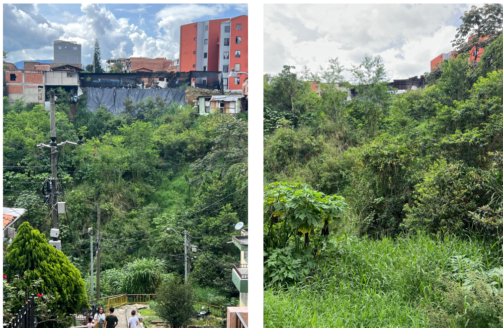
Figura 7: Fotografía registrada en sitio el 13 de junio de 2024. No se observan evidencias de nuevos desprendimientos de material en el talud. Se evidencia la reparación de la lona de plástico que cubre el escarpe del movimiento en masa.
