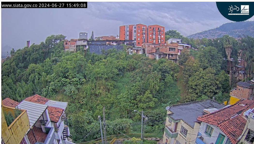
Figura 9: Fotografía registrada por la cámara de monitoreo registrada el 27 de junio de 2024. Se observa la recuperación de la cobertura vegetal en la zona afectada. Sin evidencia de nuevos desgarres que indiquen la reactivación del movimiento en masa.
