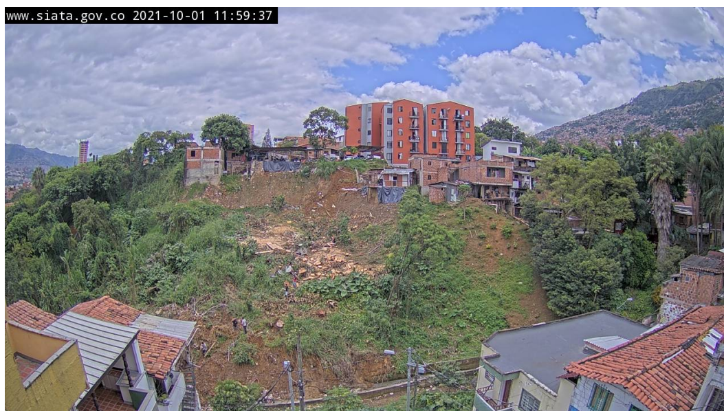
Figura 2: Fotografía registrada por la cámara de monitoreo el 1 de octubre del 2021. Se observa movimiento en masa rotacional en donde el material depositado obstruyó el canal y generó el colapso de uno de los muros de concreto de la obra que canaliza la quebrada La Bermejala.
