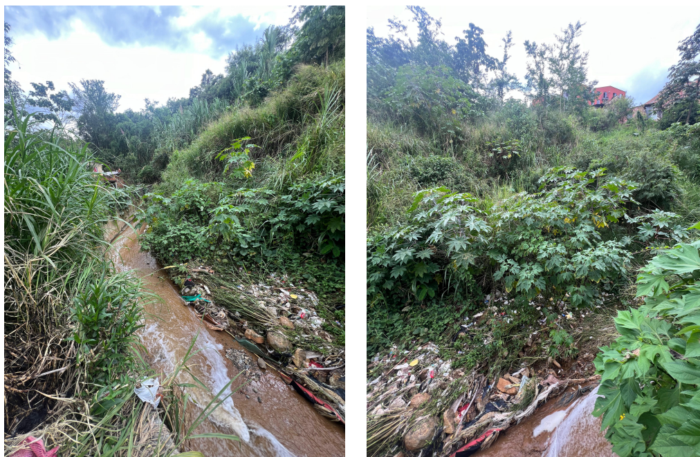
Figura 8: Fotografía registrada en sitio el 13 de junio de 2024. Se observa un flujo normal de agua en el drenaje, con ausencia de una de las caras laterales de la obra de conducción hidráulica debido al material depositado durante la generación del evento. No se evidencian nuevos desprendimientos de material.
