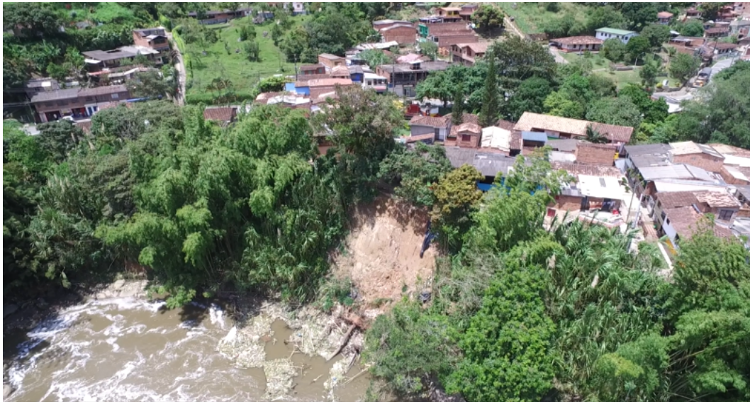
Figura 4: Imagen de sobrevuelo al talud monitoreado.
