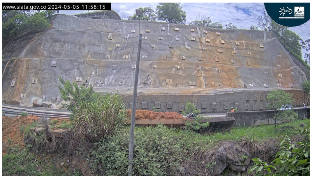
Figura 10: Fotografías de la cámara de monitoreo del deslizamiento. Fotografía registrada el 5 de mayo de 2024. No se evidencian nuevos desprendimientos de material ni variaciones en la estructura de la obra de mitigación, con respecto al año anterior en donde se construyó.
