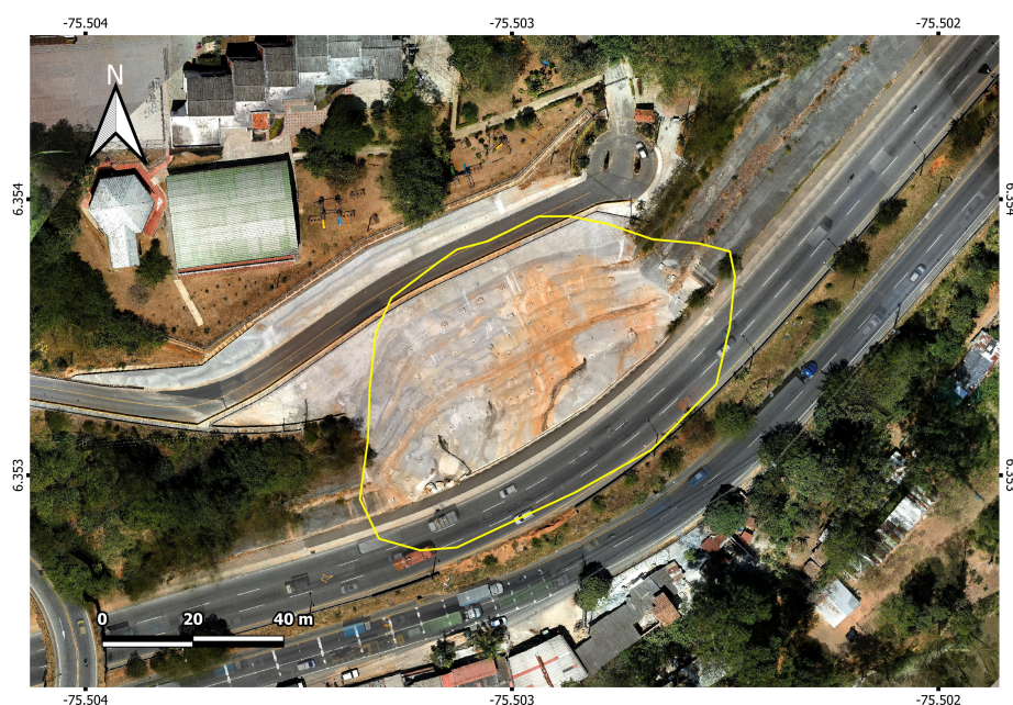
Figura 5: Ortomosaico de sobrevuelo realizado el 22 de enero de 2024 sobre el deslizamiento estabilizado en la Autopista Norte.
