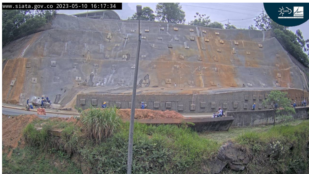
Figura 9: Fotografías de la cámara de monitoreo del deslizamiento. Fotografía registrada el 10 de mayo de 2023. Se observa talud estabilizado.
