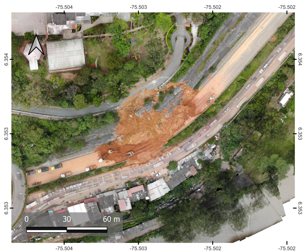
Figura 3: Ortomosaico de sobrevuelo realizado en octubre 12 de 2021 sobre el deslizamiento Autopista Norte, poco después de presentarse la emergencia.
