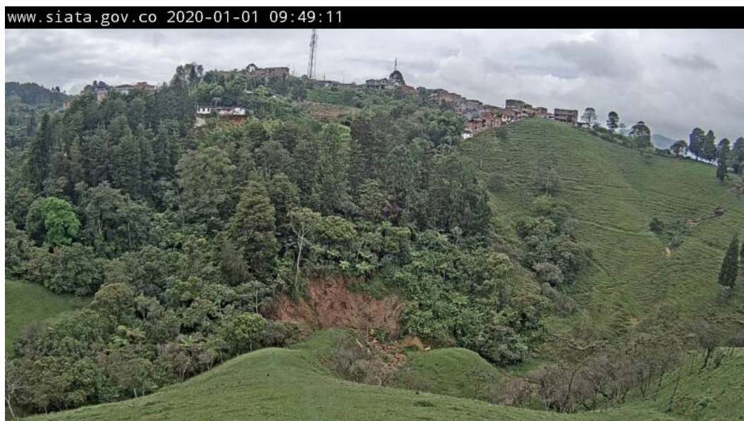
Figura 8: Fotografías de la cámara de monitoreo del deslizamiento. Fotografía registrada el 1 de enero de 2020.
