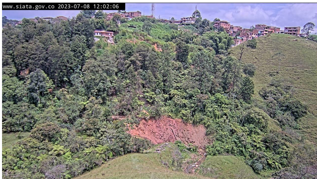
Figura 10: Fotografías de la cámara de monitoreo del deslizamiento. Fotografía registrada el 8 de julio de 2023. La erosión lateral continua activa en la parte baja del deslizamiento y se evidencian pequeños desprendimientos de material sobre el cauce.
