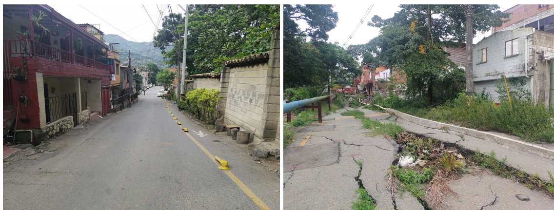
Figura 4: Fotografía izquierda tomada en agosto de 2019 a las edificaciones residenciales y vía principal del barrio Ancón Norte. Fotografía derecha tomada en septiembre de 2022 a las edificaciones residenciales colapsadas o demolidas y vía vehicular deformada en el barrio Ancón Norte.
