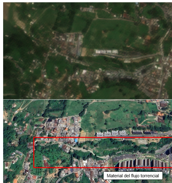
Figura 21. Flujo torrencial para 2023, zona baja.
