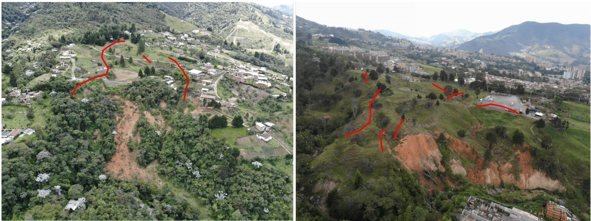
Figura 2.18: Fotografías tomadas con drones durante visitas de campo a zonas con anomalías de desplazamientos InSAR, posteriormente definidas como movimientos en masa potenciales. Las líneas rojas indican agrietamientos del terreno. Fuente de las fotografías: SIATA.
