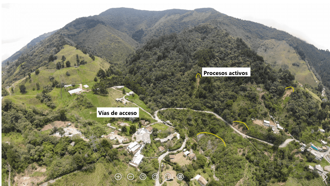
Figura 17: Imágenes tomadas con dron en la cuenca de la quebrada La Despensa
